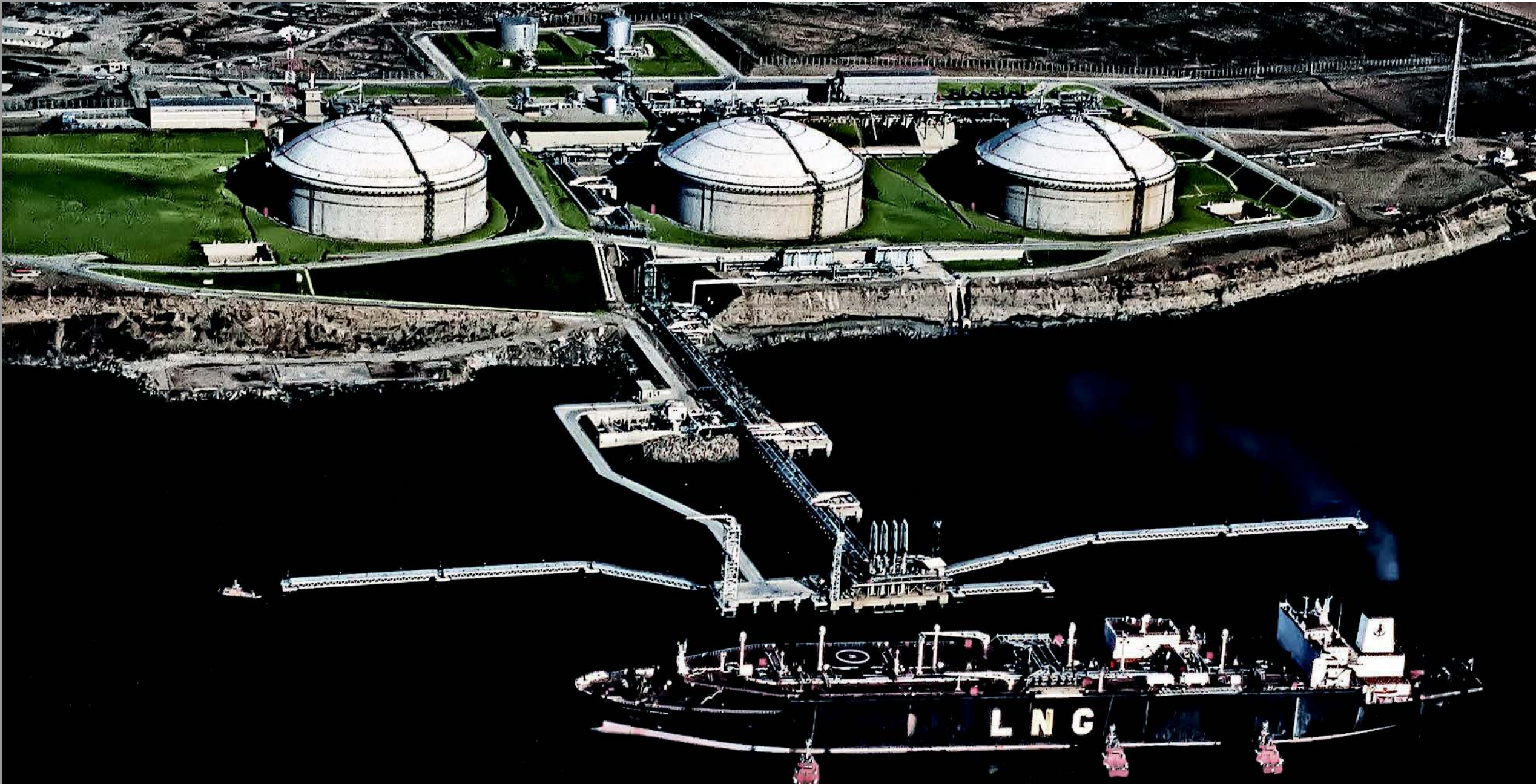
Marmara Ereğlisi LNG Terminal, Turkey "First LNG Terminal ever built in Turkey" 3x85.000 m³ Cryogenic LNG Tanks
